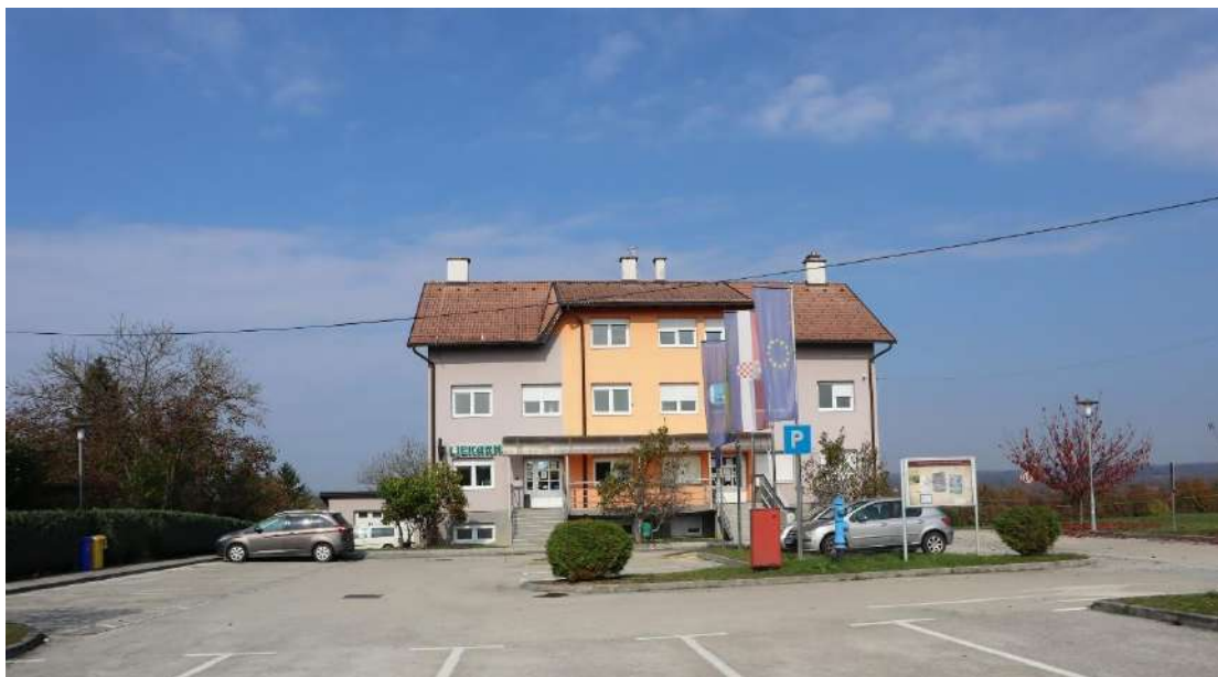
Slika 29 - Zgrada Općine (Autor: 3E PROJEKTI d.o.o.)
