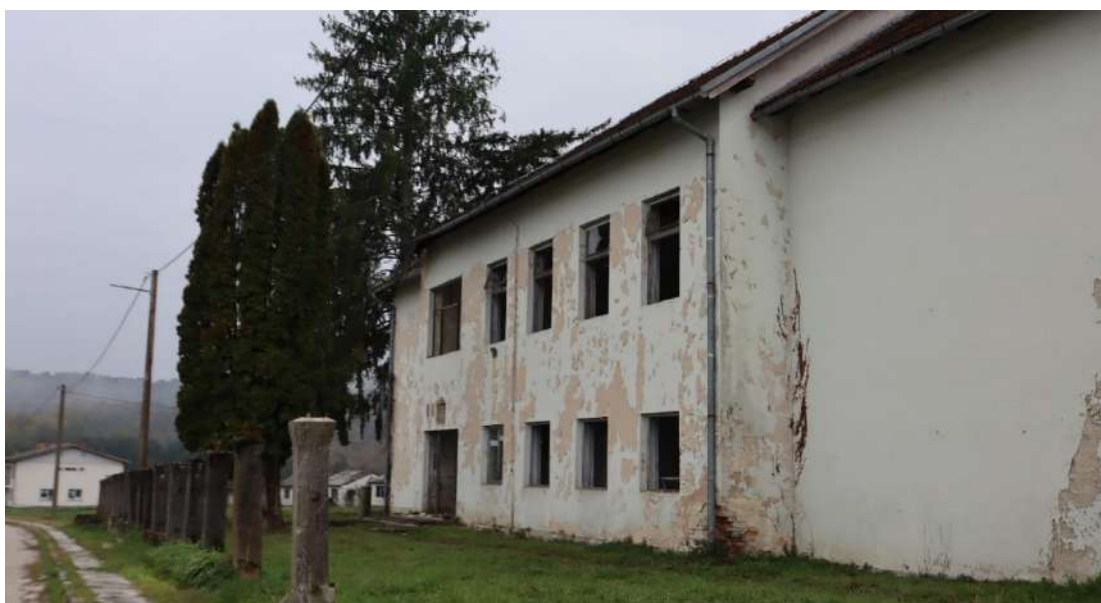
Slika 85 – Zgrada nekadašnje škole, Sjeničak Lasinjski (Autor: 3E PROJEKTI d.o.o.)
