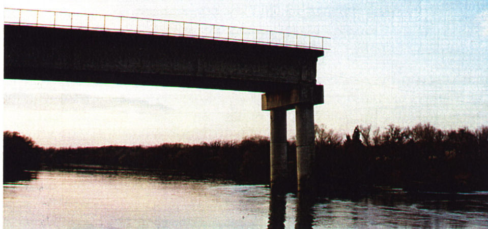
Porušeni most preko Kupe
